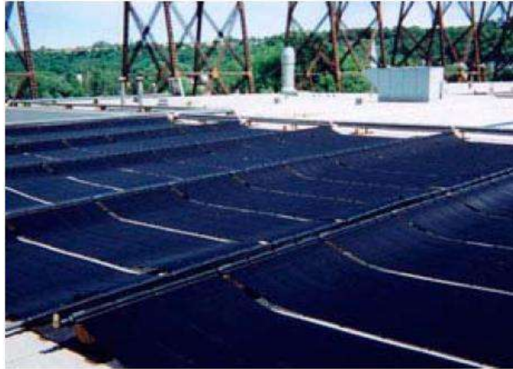
Fig.2 : Capteur moquette pour le chauffage des piscines
