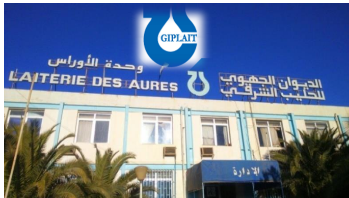
Figure 4-3: Siège de l'unité LAITERIE AURÈS -BATNA-
