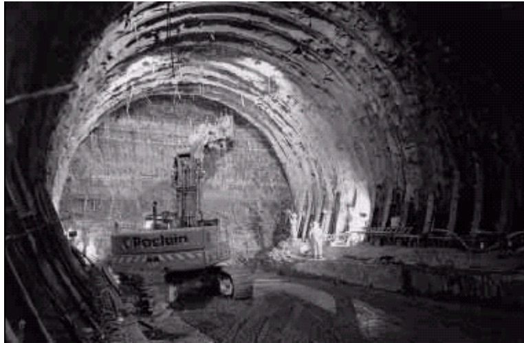
Fig. 1.6 : Creusement en pleine section.
