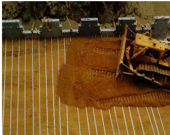
Figure1-1 : renforcement par files
