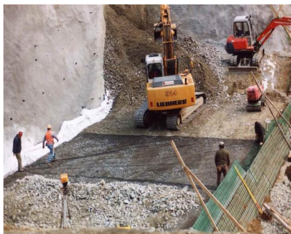
Figure1-2 : renforcement par nappes
