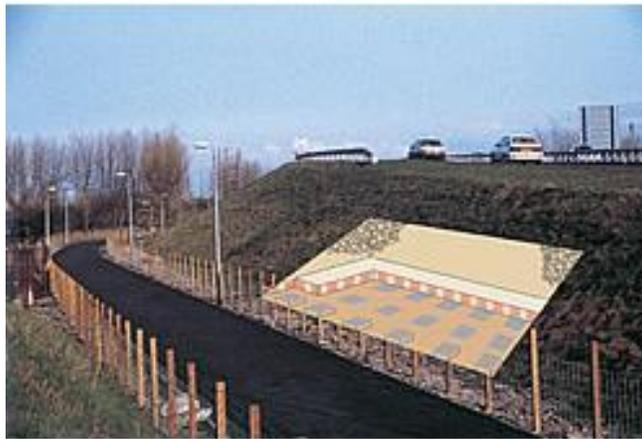
**Figure 2.11** Vue d'un remblai reposant sur une plate-forme de transfert de charge
