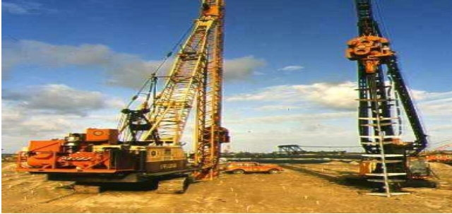
Fig.2.9 : Compactage par vibro-sonde
