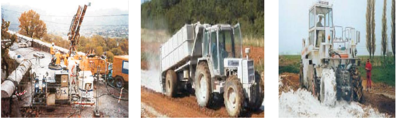
Fig.2-11 : Traitement chimique à la chaux et au ciment.
