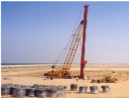
Fig.2.15 : Traitement par DV
