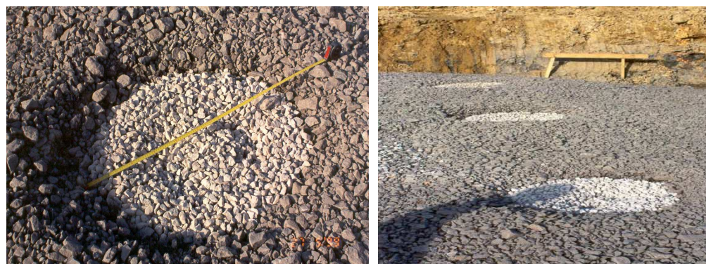
Fig 1.5 Colonnes ballastées réalisées par voie sèche [doc. KELLER]
