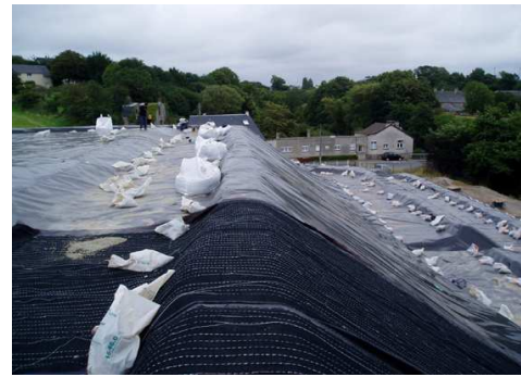
Figure I.36: Talus renforcé par géocomposites.
