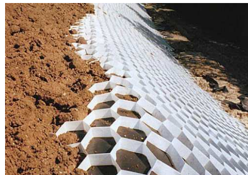
Figure I.38 : Talus renforcé par des mattes.
