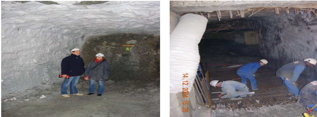
Figure I.23 : Renforcement temporaire d'une galerie par congélation.
