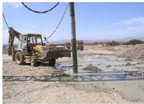
Figure I.12: Introduction du ballaste dans le trou.
