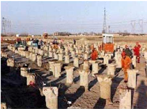
Figure I-16 : Mise en place des inclusions rigides.
