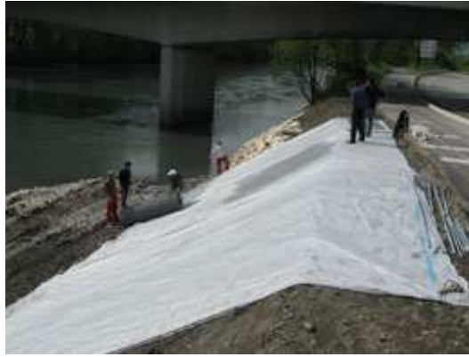
Figure I.30: Talus renforcé par géotextile.
