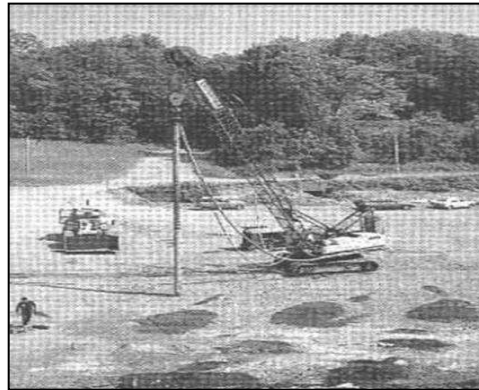
Figure I.20 : Chantier de Vibrocompactage.
