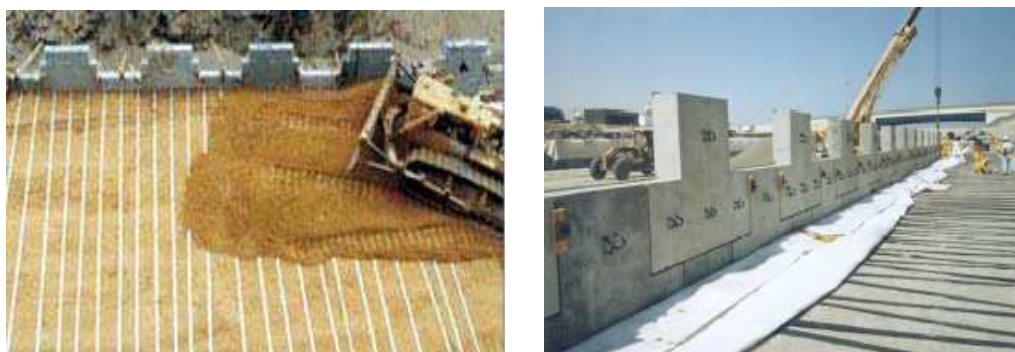
Figure I.25: Principe de la terre armée (d'après Schlosser 1983).
