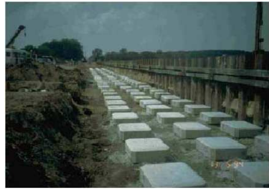
Figure I-17 : Têtes d'inclusions avant l'édification du remblai.
