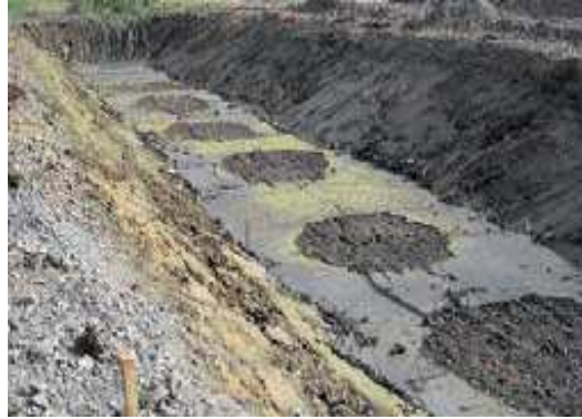
Figure I-13: Réalisation des colonnes ballastées.
