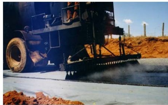
Géosynthétiques dans la construction d'une chaussée(*)
