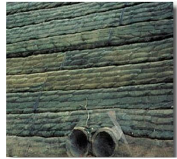
Figure 1-13 : Mur de retenue
