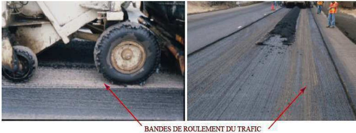
Figure (II-12) Pollution de l'interface pendant les travaux [M DIAK 2007]
