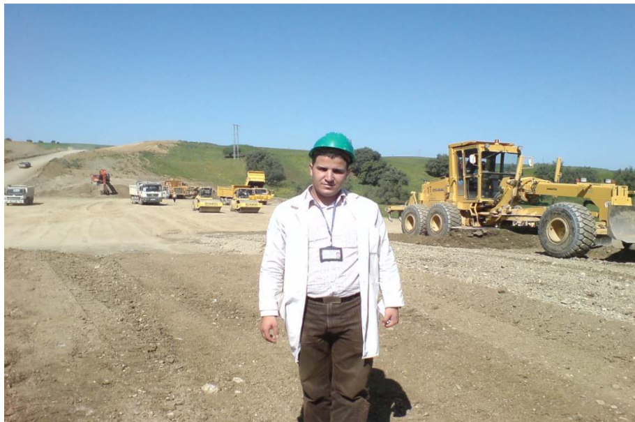
Photo A.5 : section remblai, Harrouche, comp5
