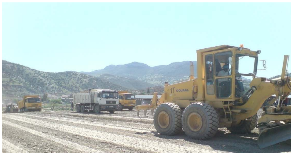
Photo A.6 : exécution de remblai, Harrouche, comp5
