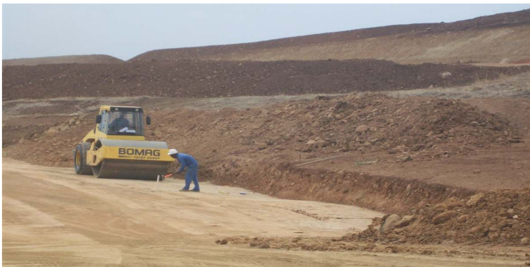
Photo A.3 : section déblai constantine, comp3
