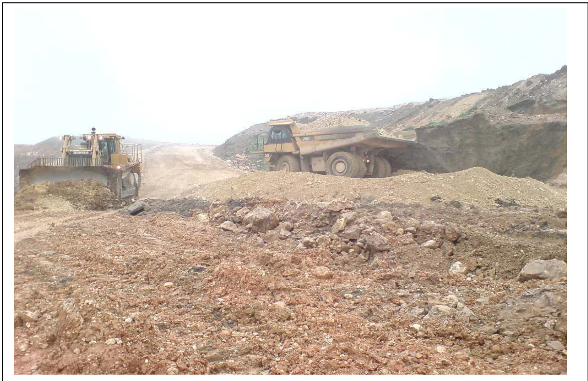
Fig.2.1- Chantier de Terrassement Autoroutier
