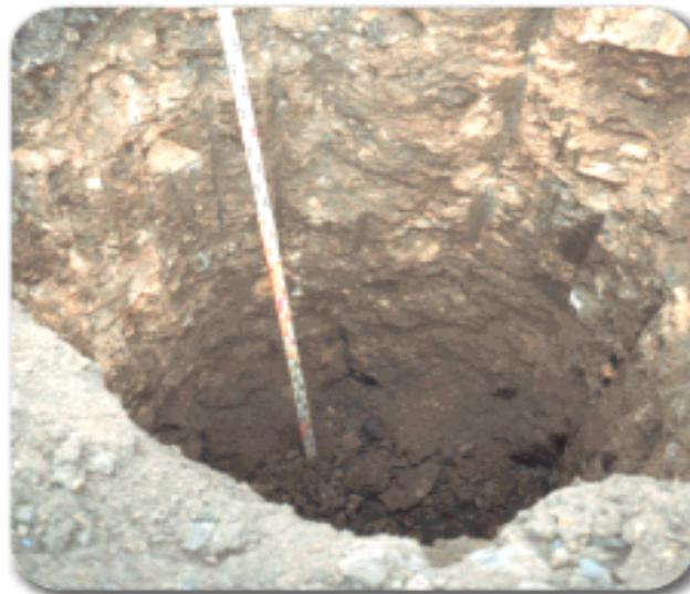
**Figure I.7** Plot ballasté avant remblaiement type (Document de G.T.S®)
