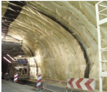
Figure I.17 : Etanchéité d'un tunnel.
