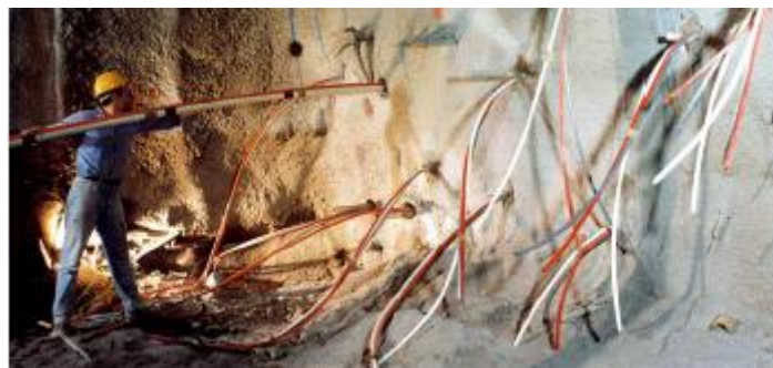
Figure III.10 : Pose de boulons en fibre de verre au front de taille.
