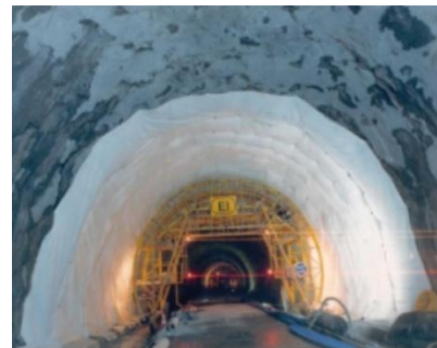
Figure I.17 : Etanchéité d'un tunnel.
