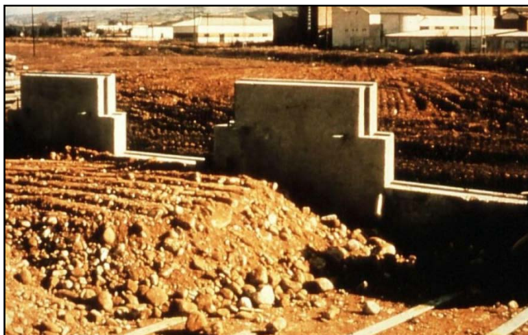
Fig.1.13 mur en terre armée.
