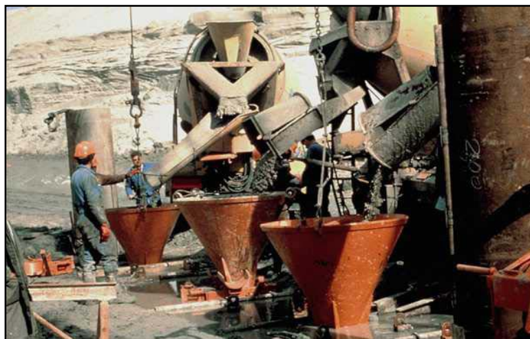
Fig.1.11 Les murs en parois moulées.
