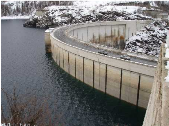
Fig. 1.3 Barrage de Tignes (côté aval). (Photo B. Juillard)
