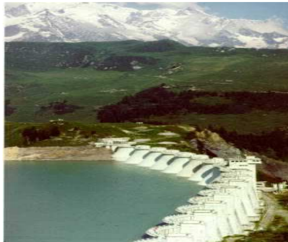
Fig.1.5 Barrage de La Girotte (photo H. Barthélémy).
