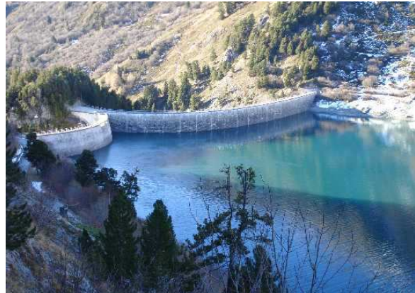
Fig. 1.4 Barrage à doubles voûtes de Plan d'Aval (Aussois). (photo B. Juillard)
