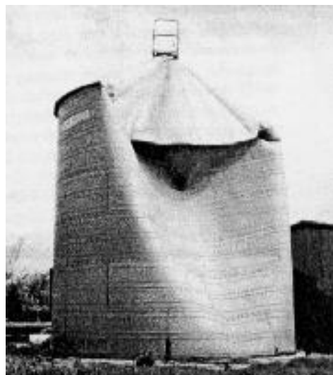
Fig I-16: Flambement de la paroi cylindrique et du toît conique sous le vent [19]
