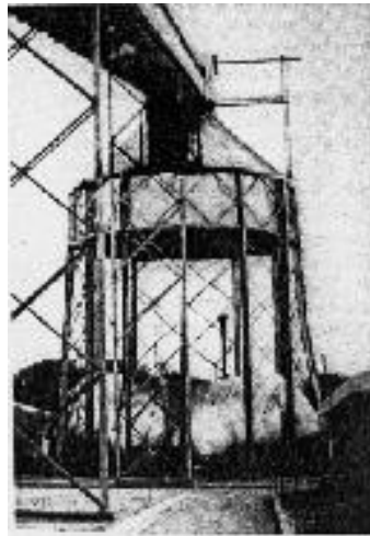
Fig I-5:Chute de la trémie [9]
