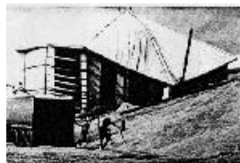
Fig I-7:Éclatement d'un silo à assemblage mal détaillé [9]
