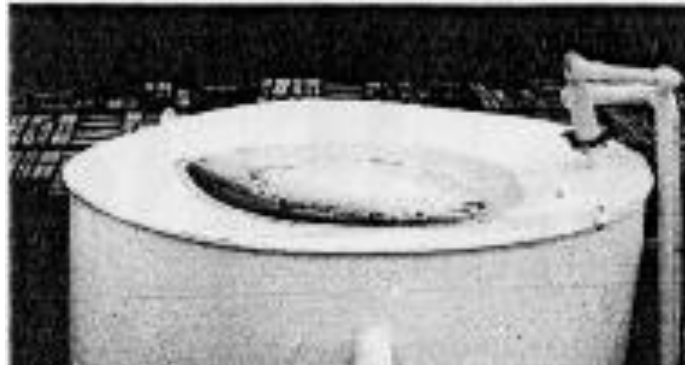
Fig I-15: Toît conique après leclaquement à travers le flambement [9]
