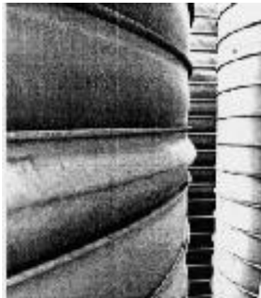
Fig I-11:Flambement au-dessus du support des parois des silos à bague raidie [9]
