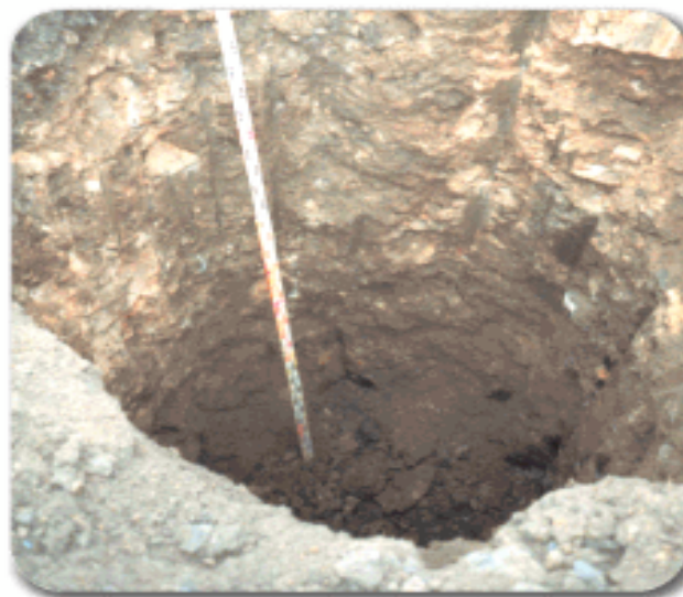
Figure III.7 Plot ballasté avant remblaiement type (Document de G.T.S®)
