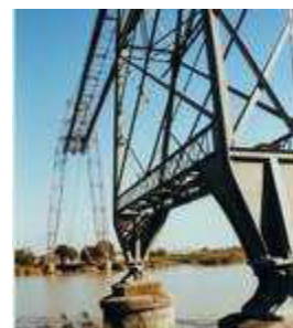
Fig2.22 : Le pont transbordeur du Martrou
