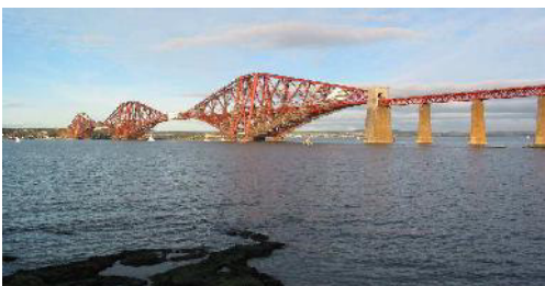
Fig2.5: Pont du Firth of Forth (Écosse), réalisé en 1890, avec deux travées de 521m.
