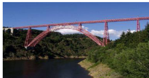
Fig2.6: Pont viaduc de Garabit (Cantal), achevé en 1884, avec une portée de 165m.
