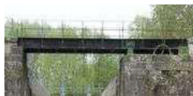
Fig2.19 : Pont oscillant des Dames (canal du Nivernais)
