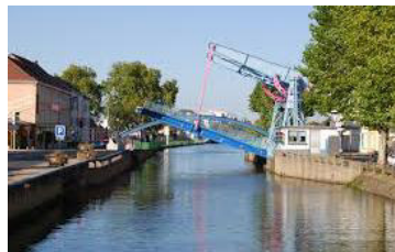
Fig2.12 : Pont basculant de Montceau-les-Mines
