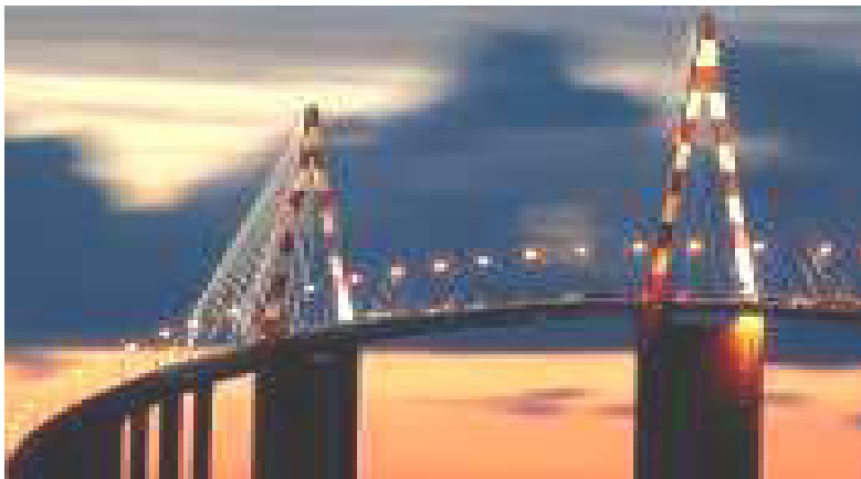
Fig2.10: Le pont à haubans de Saint-Nazaire en Loire Atlantique.
