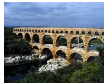
Fig2.1: pont du Gard (en.wikipedia.org)
