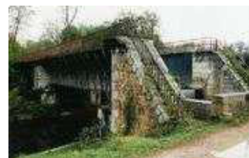
Fig 2.20 :Le pont-rivière d'Oudan (canal de Roanne à Digoin)
