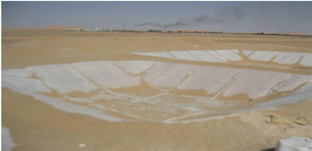
Photo III.1 : Bourbier étanche avant le forage (Hadj Abbas, 2011)
