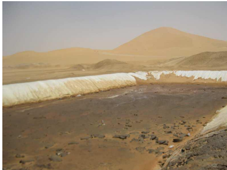
Photo III.2 : Bourbier après une opération de forage (Hadj Abbas, 2011)
