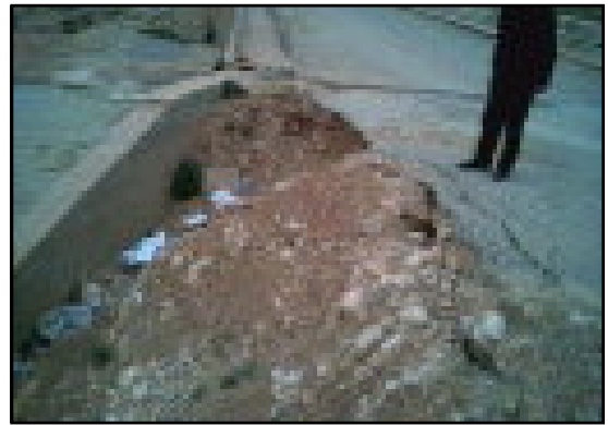
b- destruction du gabionnage
