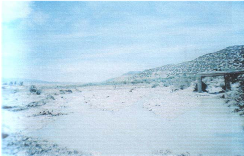
Destruction du pont de M'chounèche
