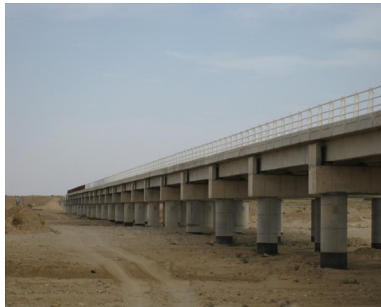
Figure 4.2 : Vue d'une partie du pont d'accès côté EL Meita
