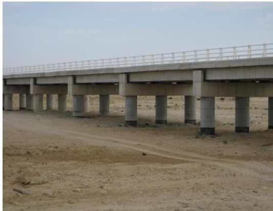
Figure 4.5 : Vue d'une partie de pont d'accès côté intermédiaire
