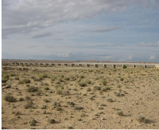
Figure 4.1 : Vue générale du pont d'Oued Medila à Tebessa
