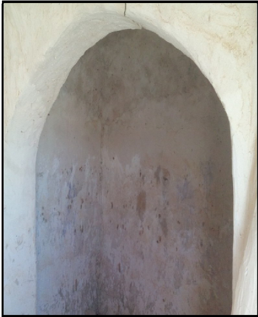
صورة رقم 15: السقوف تبنى بتقنية الأقباس
