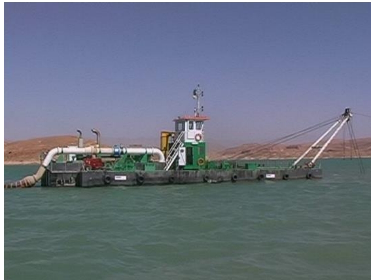
Figure 2.10 : Opération de dragage du barrage de Foum el Gherza (Source ANBT)
