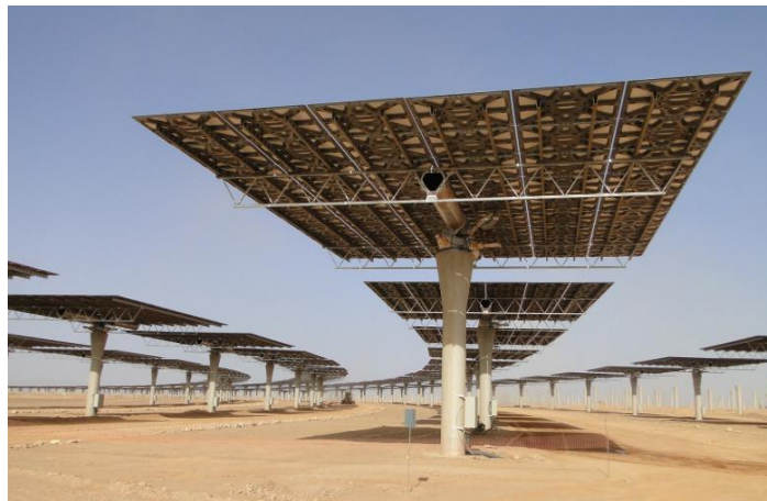
Figure 1.18. Héliostat de SENER de 175.7 \text{ m}^2 [41].
