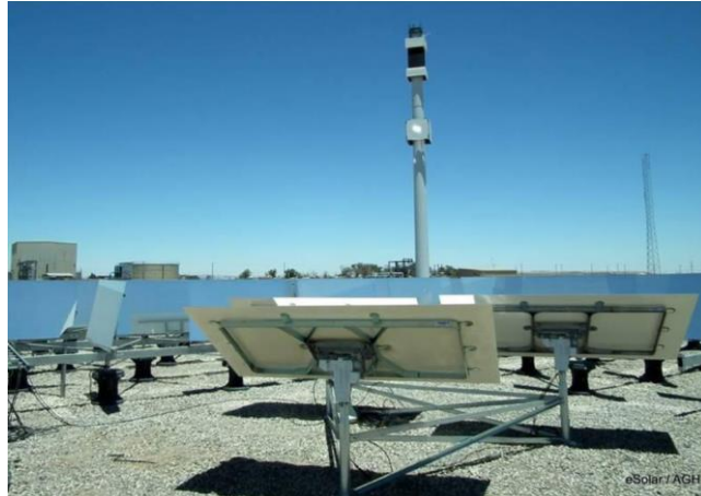
Figure 1.20. Héliostats SCS5 de 2 m 2 [43].
