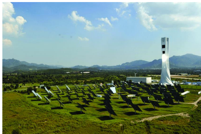
Figure 1.12. Centrale solaire à tour Dahan.
