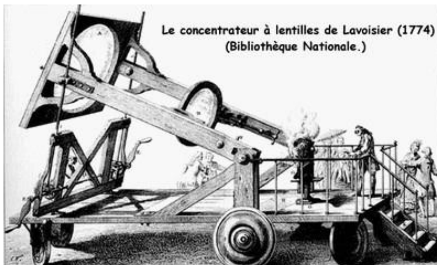
Figure 1.3 : Le concentrateur à lentilles de Lavoisier (1774) [MAT, 2012].
