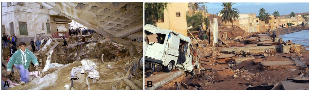
Figure 06. A : les effets destructifs après les meurtrières inondations de Bab El Oued du 10 novembre 2001, une catastrophe a provoqué plus de 700 décès et des pertes économiques considérables (source : www.elwatanlafabrique.files.wordpress.com ). B : les inondations catastrophiques de Ghardaïa du 3 octobre 2008, à cause d'un débordement brutal du Oued Mizab, a provoqué des pertes humaine et matérielles innombrable (Source : www.algeriepatriotique.com ).
