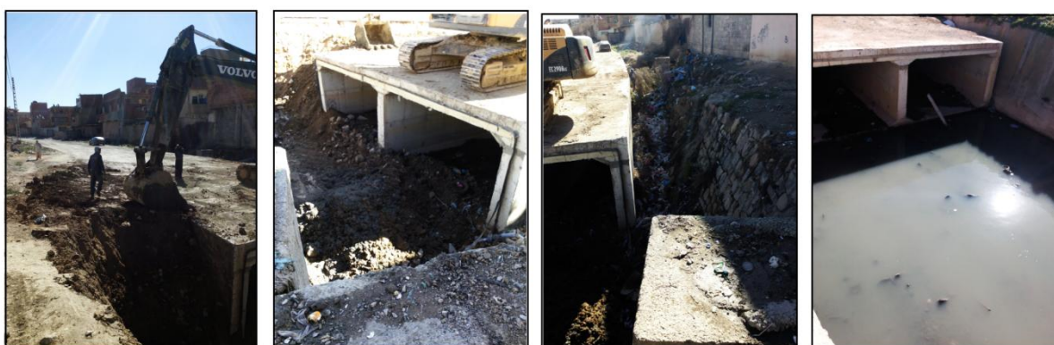
Figure 94. Les canaux dans les dernières phases de réalisation, le problème des déchets, boues et la réduction de la largeur de l'oued, partie amont du canal ceinture, près de la cité administrative (31/01/2017).
