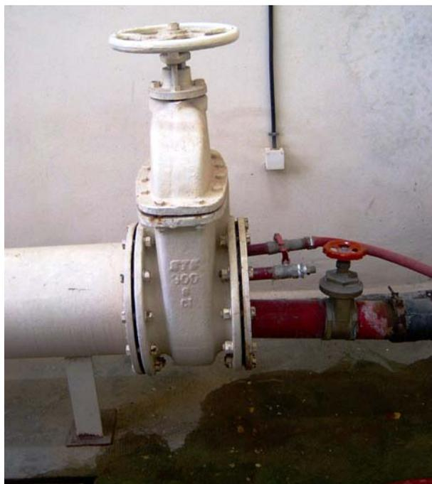
**Photo.3.10.** Vanne et robinet vanne de régulation des débits
