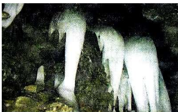
Fig. I.5. Arrivée d'eau gelée dans le tunnel de Galibier, [(Mercusot et al , 1999)]
