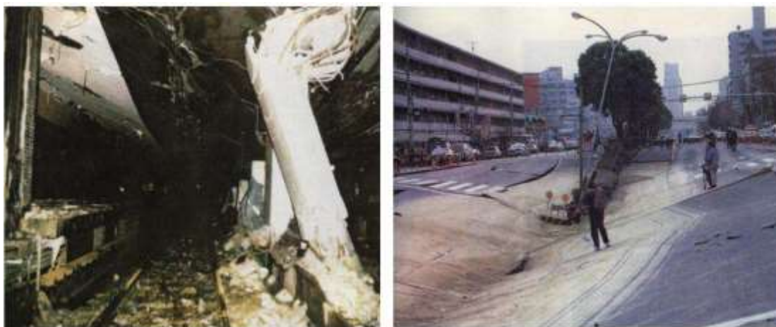
Fig. I.20 : Représentation des dommages sur une section actuelle de la station de Métro de Daikai après le Tremblement de Terre de 1995 Hyogo-ken Nanbu [(Liu, 2008)].
