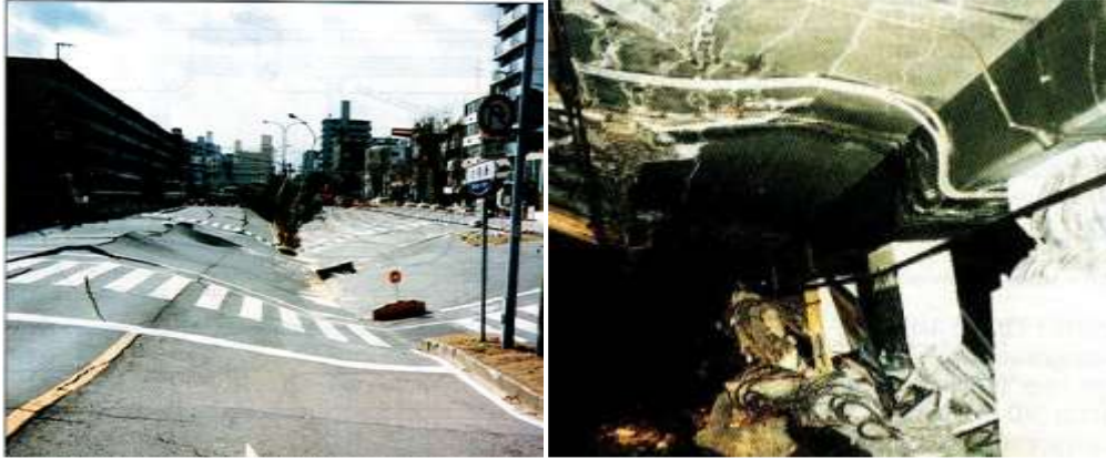
Fig. I.1. Effondrement de la route nationale au-dessus de station de métro de Daika endommagée par un tremblement de terre (Japon, 1995), [(Yoshida et al., 1996)]
