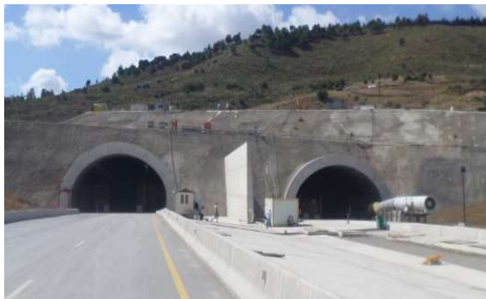
Fig. II.1 : Vue générale de deux tubes du tunnel T1 (document de projet)
