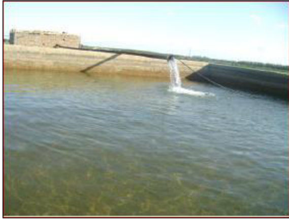
-Bassin d'accumulation des eaux pompées d'un forage bénéficié dans le cadre du PNDA-
