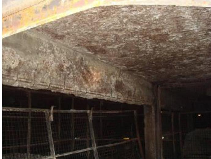
**Figure I.20 :** Eclatement du béton suite à un incendie de parking [12]
