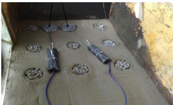
Figure I.14 Colonne ballastées ordinaire
