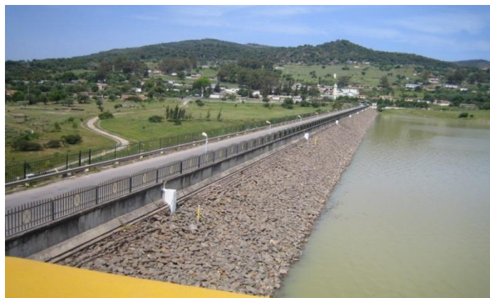
Photo 5.3. La digue du Barrage Cheffia. (cliché :CH.bouhadeb, 2016)
