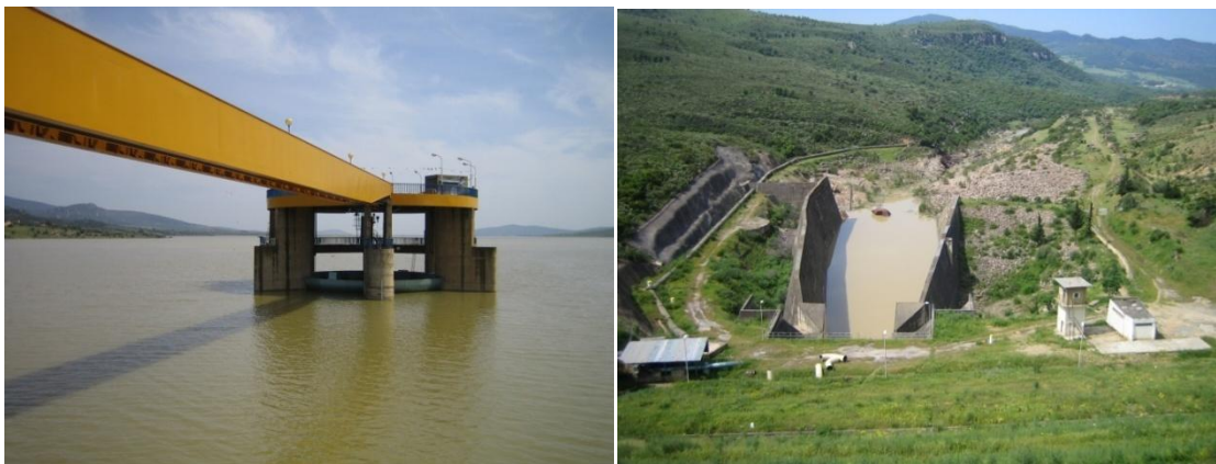
Photo 5.5. Evacuateur de crues. (cliché :CH.bouhadeb, 2016)
