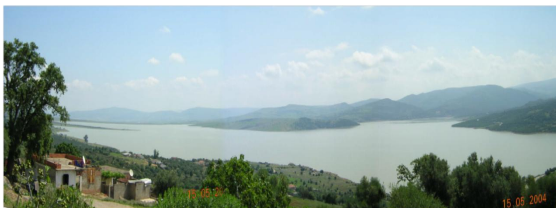
Photo 5.1. Réservoir du barrage CHEFFIA. (cliché :ANBT, 2004)
