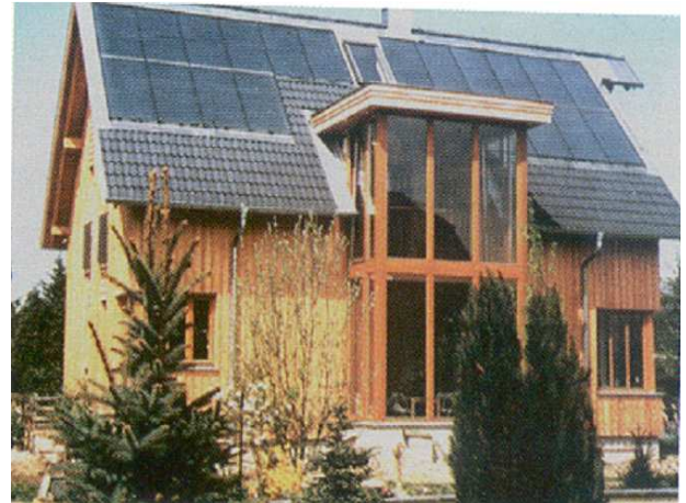
Figure I.4. Maison individuelle avec des collecteurs solaire.
