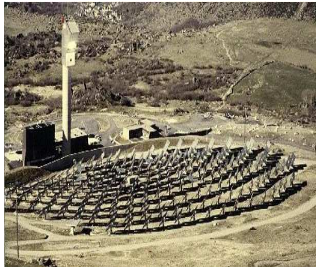
Figure I.8. Photo de la centrale Thémis (France).
