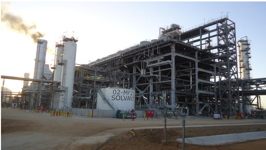
Figure V.9 Vue sud-est du mégatrain
