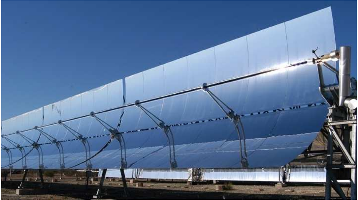
Figure 4.4: Capteur cylindro-parabolique.
