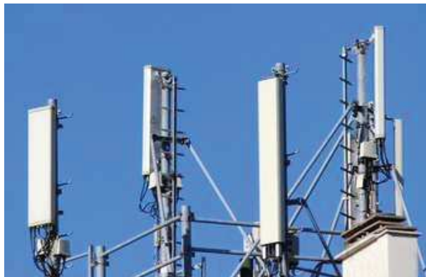
Figure I.6 : Exemple de BTS.
