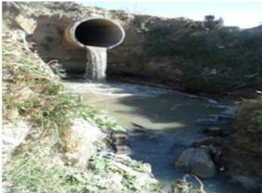
Rejet des eaux usées
