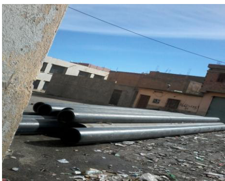
Photo N° 07 : Conduites en PEHD
