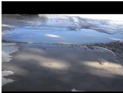
Photo. 08 : Fuite d'eau à Z'mala (2015)
