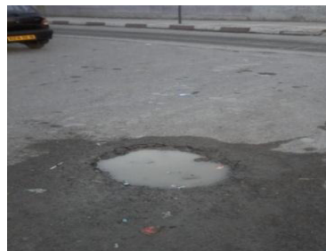
Photo. 09 : Cassure de la conduite (Bouakal2015)
