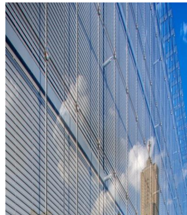
(b). Avec protection solaire.
