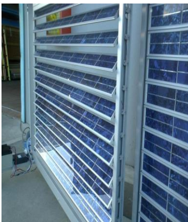
Figure I.3 : Protections solaires dotées des panneaux photovoltaïques (PV), Fossa et al. [6].
