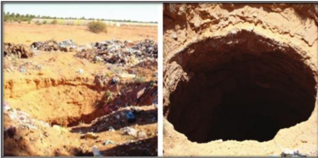
Figure 2.7 Photos de l'affaissement d'EL M'Rara (Kolli, A. 2012).
