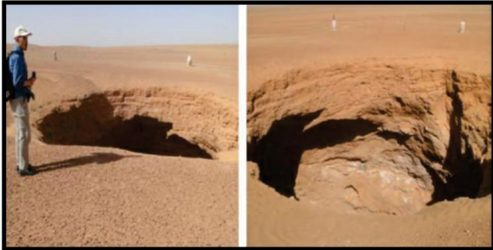
Figure 2.6 Photos de l'effondrement Sahb-Elbir (Kolli 2012).
