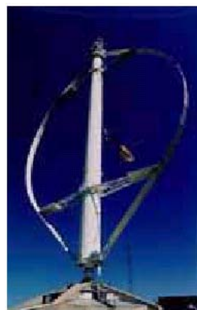
Figure 1.2 Eolienne à axe vertical de Cap Chat
