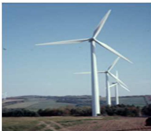
Fig. I.18 Exemple d'une éolienne à axe horizontal.
