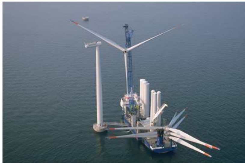
Fig. I.23 Montage des éoliennes de 2.3MW(Danemark) par un navire spécialisé mise en place du rotor à 80m au dessus de l'eau.
