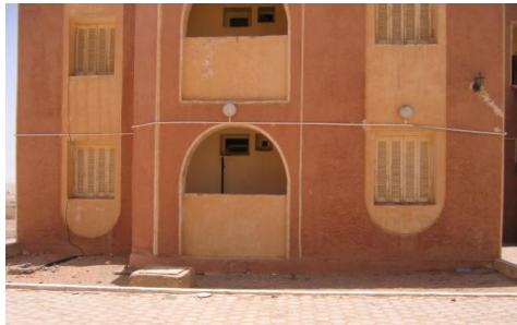
Fig 1.3: Confort thermique dans un habitat (habitat passif) [24]. (Photo de l'Unité de Recherche Appliquée en Energies Renouvelables – URAER, Ghardaïa)
