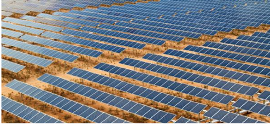
Figure I-3 Modèle solaire. Plus grand installation solaire-un 13,78 MW de puissance solaire photovoltaïque (Chine). [5]
