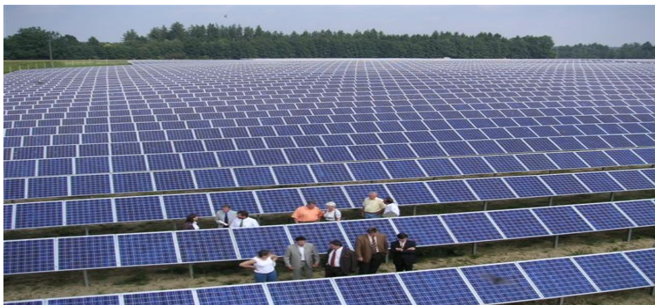
Figure I-2 Champs photovoltaïque en Allemagne. [10]
